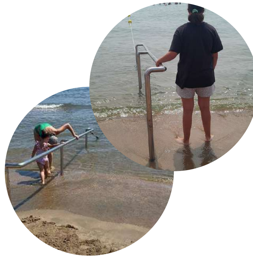
2 baranes amb línia de vida per accedir a l'aigua
